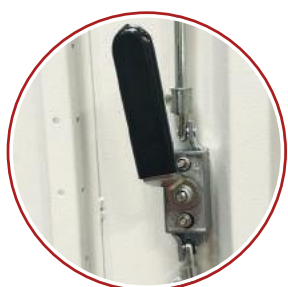
System zamknięcia drzwi biernych
