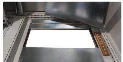
Nowy system podparcia płyty montażowej
