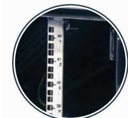
Нумерация балок RACK обеспечивает удобную сборку
